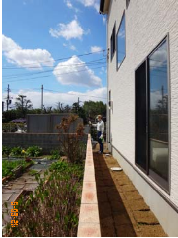
62. K09土中コンクリート杭を西へ向かって撮影
