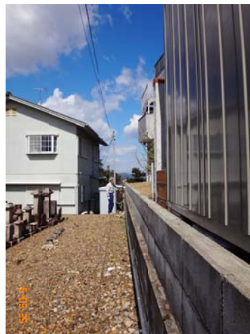
27. K03 コンクリート杭を北へ向かって撮影
