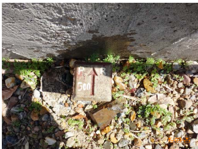
30. K03 コンクリート杭
