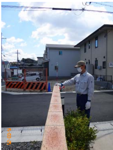
66. K10コンクリート杭を南へ向かって撮影
