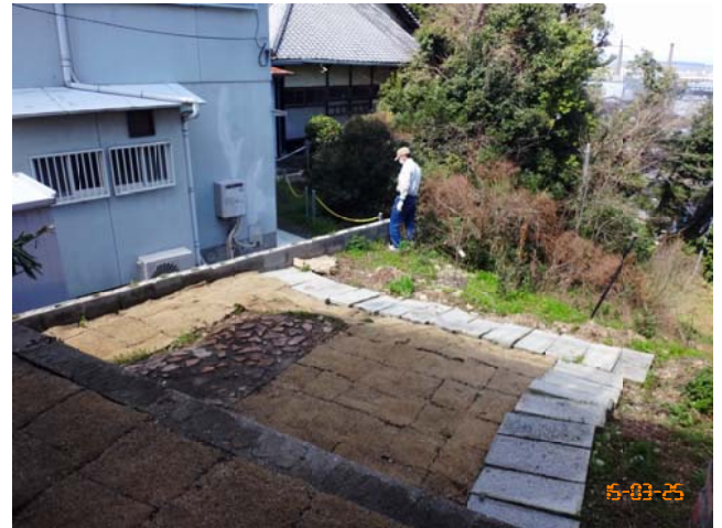
41. K05 コンクリート杭を北西へ向かって撮影
